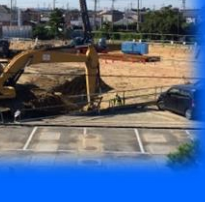
重機が入り工事の始まり
